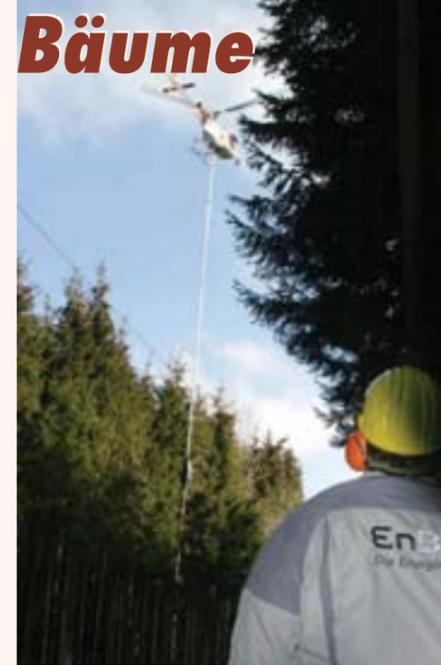
Schwer zugängliche Stellen entlang von Hoch- und Mittelspannungsleitungen werden per Helikopter von überhängenden Ästen befreit.
