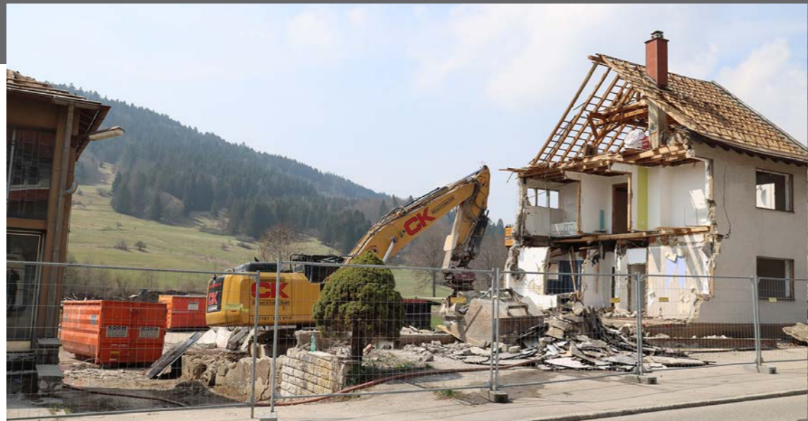
Abbruch von Wohn- und Fabrikgebäuden im Areal Neue Straße...
