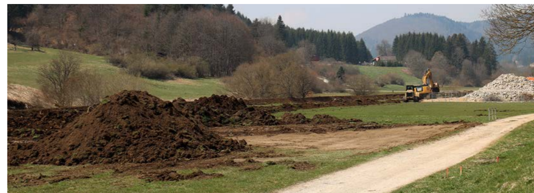
Erste Erdbewegungen zum Bau der Teilumgehungsstraße
